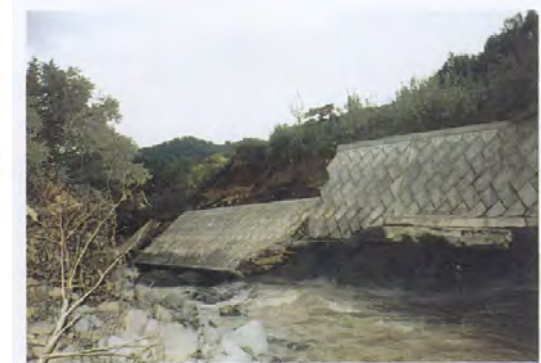
写真 2-3 基礎部の河床洗掘による護岸被災事例
