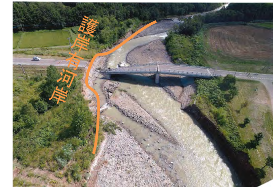
写真 2-3 基礎部の河床洗掘による護岸被災事例
